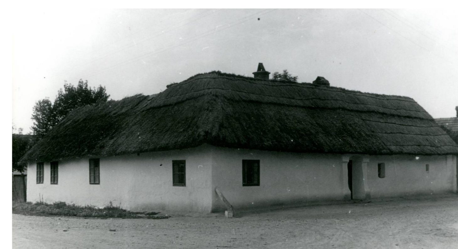
Sedliacky dom pani Sokiovej na rohu súčasnej Lipnickej a Miloslavovskej ulice dnes už nestojí, obec ho v r. 1986 po smrti majiteľky z dopravných bezpečnostných dôvodov dala odstrániť.
