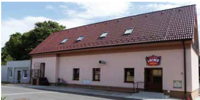
Budova bývalého kultúrneho domu s prístavbou v súčasnosti zo strany Mariánskej ulice.
