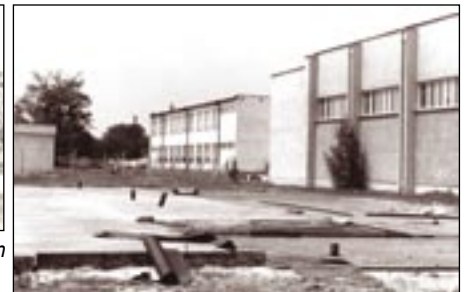
Výstavba telocvične na školskom dvore
