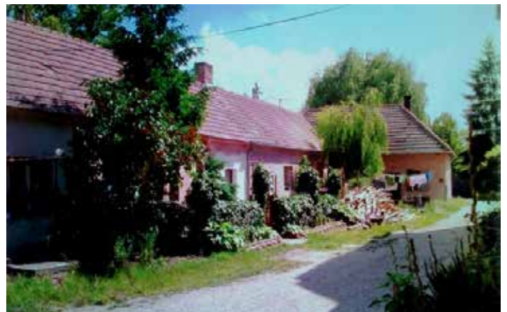
2004, byty, vpravo budova správy hospodárstva
