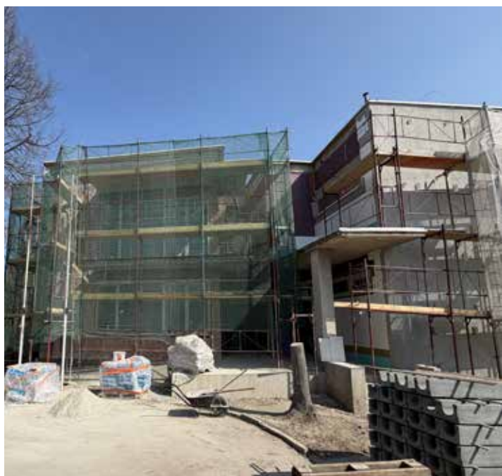
Pracuje sa na fasáde obecného úradu
