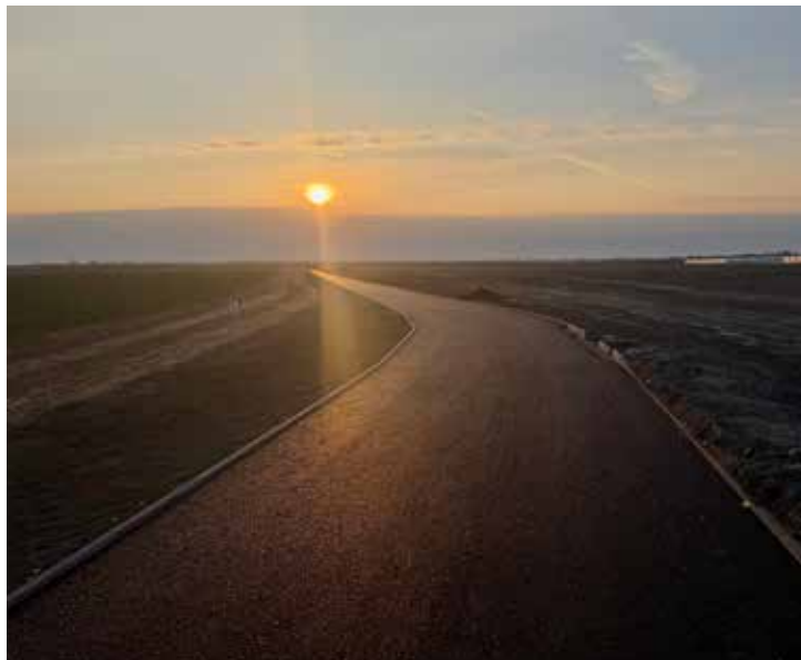
Prvá vrstva asfaltu na cyklotrase
