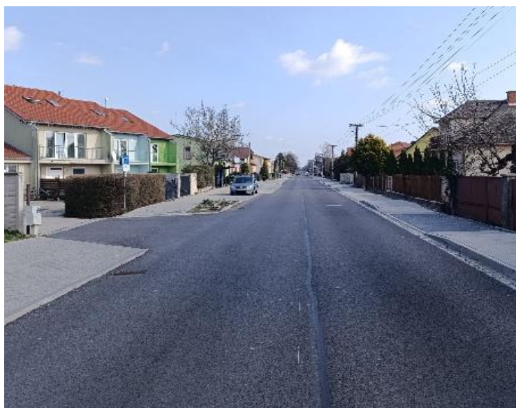
Časť chodníka na Lipnickej je už dokončená
