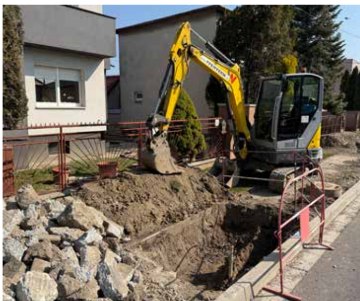
Výmena hydrantov a prípojok na Lipnickej
