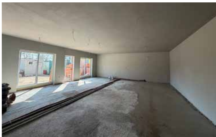
Práce prebiehajú aj v interiéri
