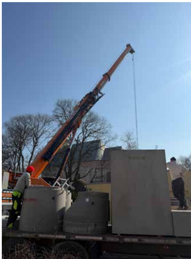
Osádzanie retenčných nádrží
