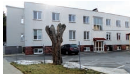
Novopostavená budova pre prevádzkové zázemie dojčenského ústavu.
